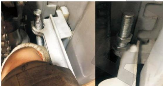
Рис. 8. Монтаж трубы. Вначале не затягивать крепления с двух сторон, чтобы деталь не упала.
