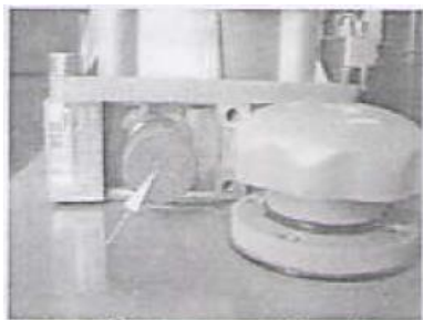
Схема насосной станции – редукционный (перепускной) клапан
